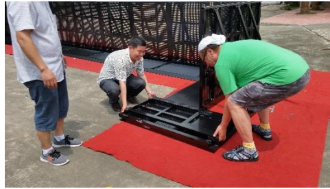
設置したい場所まで2名で運ぶ 土台の内側、外側に注意する
