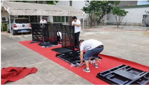
設置したい場所まで2名で運ぶ 土台の内側、外側に注意する
