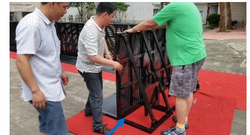
パネルを立てても土台のボルト はまだ止めない
